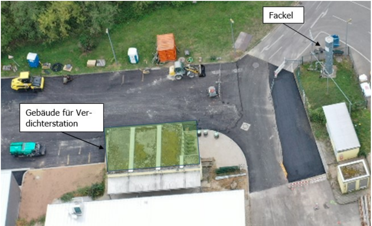
Abbildung 1: Verdichterstation, Fackel und BHKW räumlich weit voneinander entfernt
