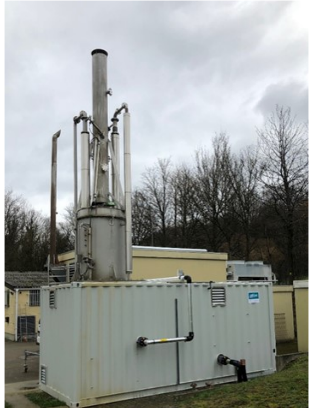
Abbildung 5: Fackel im Container integriert (nachher)
