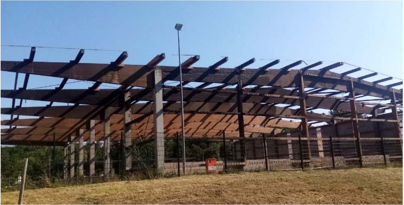
Abbildung 3: Müllumladehalle während der Abbruchmaßnahmen
