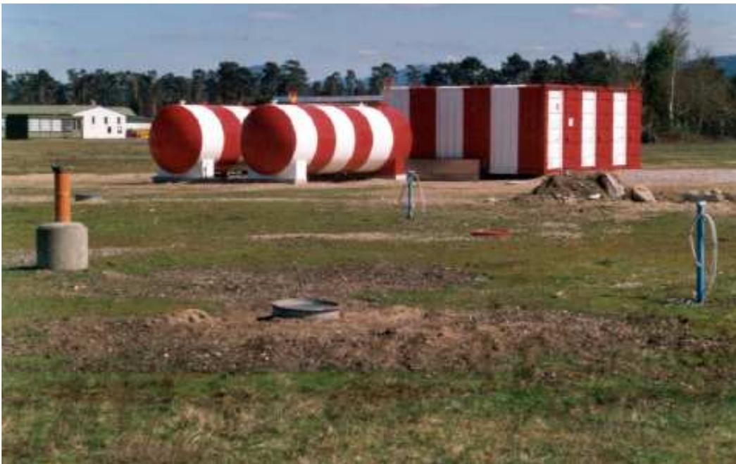
Foto 4: Die meisten Grundwasserbrunnen und –leitungen sind unterirdisch rings um die Sanierungsanlage verlegt . Kontrollmessstellen ragen aus dem Boden heraus.
