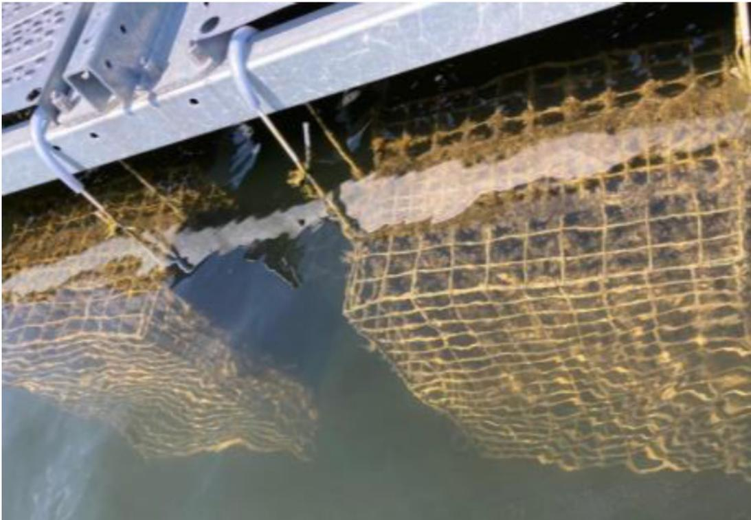
**Abb. 16:** Unter einer FPV-Anlage angebrachte Gitterkörbe für Fische (Quelle: BayWa)
